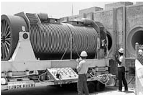
Завантаження відпрацьованого ядерного палива до сухого сховища горизонтального типу
